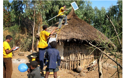
Installation eines Solar Home Systems im Dorf.
