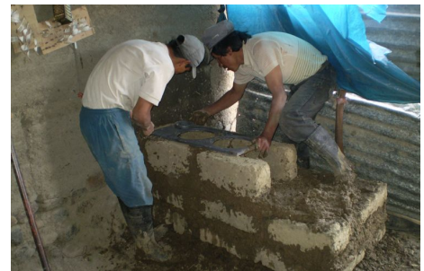
Zwei lokale Handwerker beim Bau eines neuen Herdes mit Kamin.
