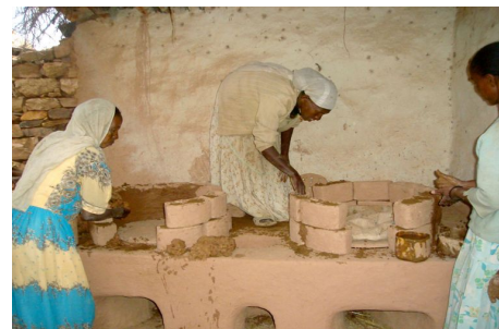
In gemeinschaftlicher Arbeit errichten die Frauen den oberen Teil des Mogogo-Ofens mit vorgefertigten Ziegeln.
