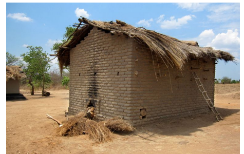
Die traditionellen Trocknungsanlagen verbrennen Holz sehr ineffizient.
