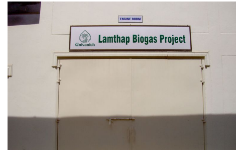
Maschinenraum des Biogasprojektes der Firma Univanich.
