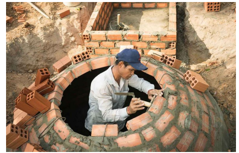
Bau einer Biogasanlage mit Ziegel und Lehm.
