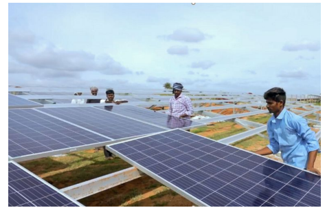
Am Bau der Anlage haben tausende Arbeiter*innen aus vielen Teilen des Landes mitgewirkt.
