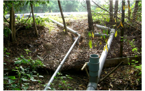
In Röhren wird das gefasste Biogas (Methan) abgeleitet und in Heizkesseln zur Stromerzeugung verbrannt.
