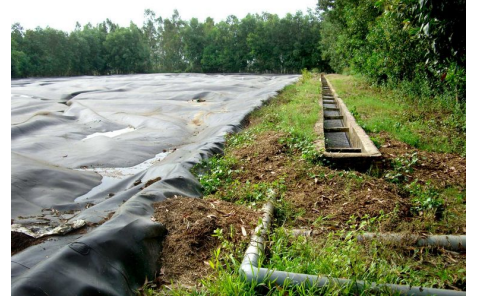
Eine Membran fängt das klimaschädliche Methangas auf.
