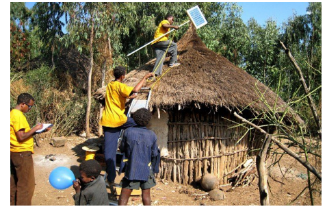
Installation eines Solar Home Systems im Dorf.
