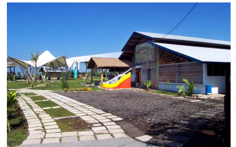
Der Umweltpark nach der Sanierung. Das Pilotgebäude wurde zu einem Ausbildungszentrum umfunktioniert.
