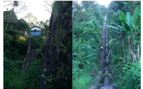
Die Elektrizität wird durch die Kraft des Wassers gewonnen, welches durch die Druckleitung fällt und die Turbinen am unteren Ende antreibt.
