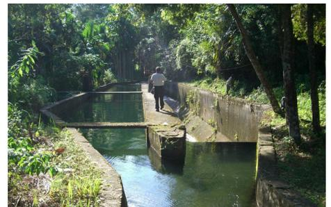
Der Aquädukt führt das Wasser vom Staudamm und seinem Reservoir durch den Dschungel zur Druckleitung.
