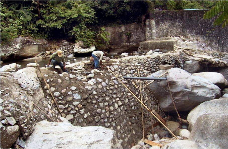
Der Staudamm besteht aus einfachen, lokal abgebauten Materialien. Die gesamte Konstruktion ist historisch und stammt aus der niederländischen Kolonialzeit.
