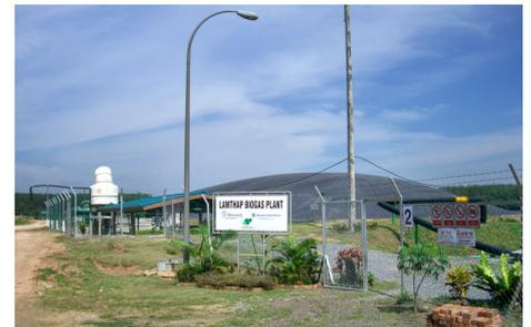
Das Abwasserbecken wird mit einer Membran bedeckt, das das klimaschädliche Methangas (Biogas) auffängt.
