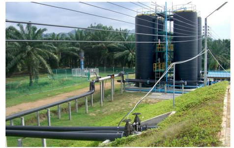
Das Methangas wird durch die Verbindungsrohre zur Gasreinigungsanlage geleitet und danach im Stromgenerator verbrannt. Dieser erneuerbare Strom wird in der Anlage genutzt und ins Stromnetz eingespeisen.
