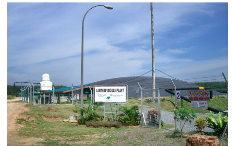
Das Abwasserbecken wird mit einer Membran bedeckt, das das klimaschädliche Methangas (Biogas) auffängt.
