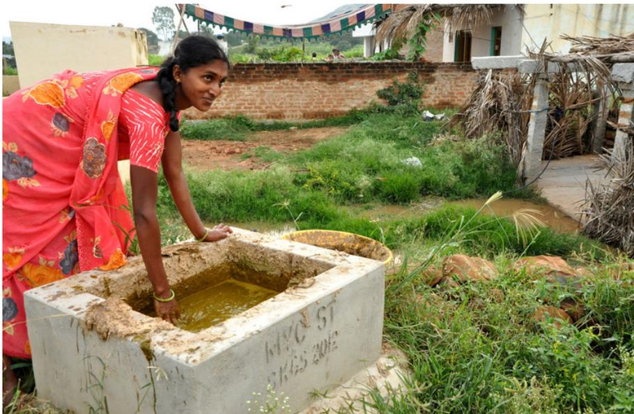
Im Mischtank wird Dung mit Wasser vermengt. Die Inschrift am Einlass dient der Transparenz und trägt dazu bei, die hohen Qualität-Standards zu halten. 'myc' steht für myclimate.
