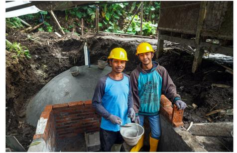
Nathun und sein Sohn arbeiten an der Konstruktion einer festen Kuppel für den Bau einer Biogasanlage. Foto: Gema Ramadhan
